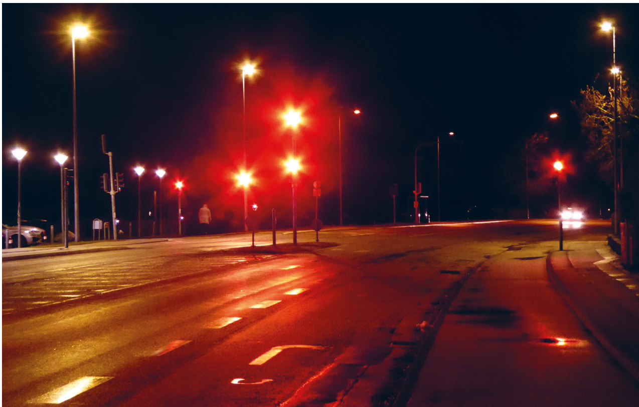
Lysset fra signalanlægget kan virke blændende, når det er mørkt. Korrekt vejbelysning udligner kontrasten.
